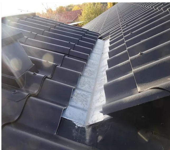
Driftseksempel: SKOTRENDE mellem to tagflader. Skotrender skal efterses og driftes jævnligt.
