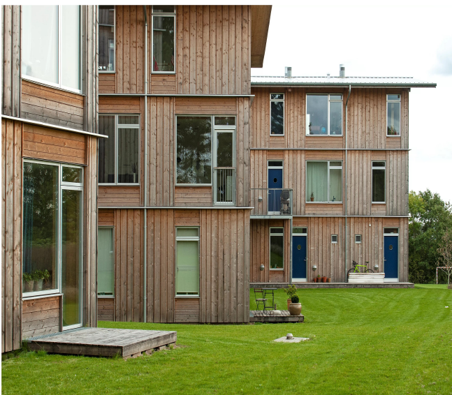
Organiske materialer i klimaskærmen, men god konstruktiv beskyttelse fra inddækninger og store tagudhæng. Mulighed for enkel drift.
