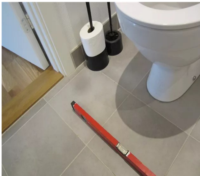
Driftseksempel: VANDRET GULV ved dør betyder øget drift, og der skal monteres et metalprofil på dørtrinnet for at beskytte trætrinnet.
